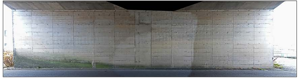
(a) 床版までの高さが高い橋梁
