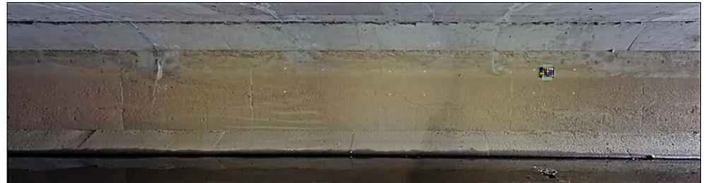
(b) 床版までの高さが低いため屈みながらの点検が必要な橋梁
