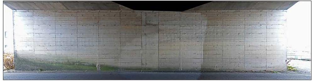
(a) 床版までの高さが高い橋梁
