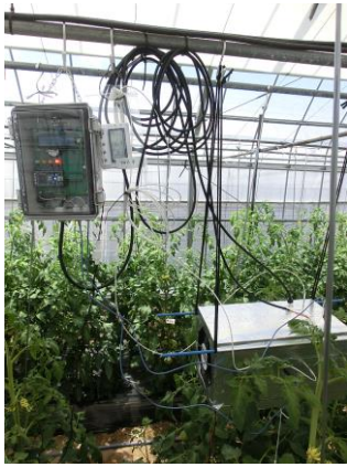
図3 ハウス施設への設置
