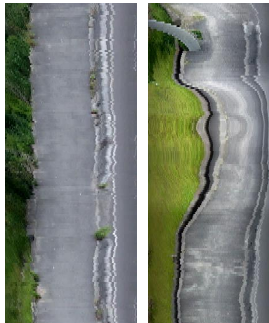
図4 安定走行時(左)と側溝転落直前(右)の比較画像
