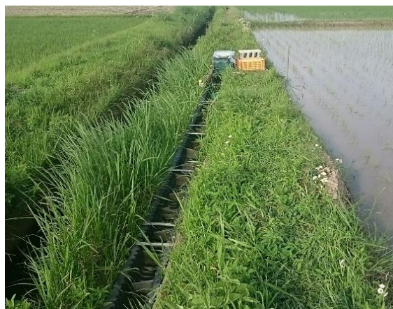
図1 現地計測を行った水田魚道 (左: 海津市南濃町1, 右: 海津市南濃町2)
