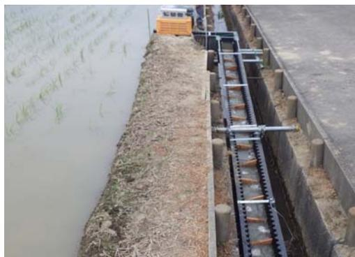
図1 現地計測を行った水田魚道 (左：養老郡養老町, 右：本巣郡北方町)
