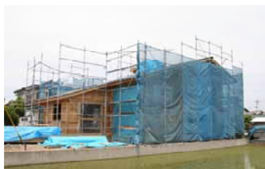
図5 建築中の住宅
