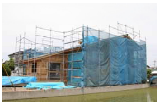
図5 建築中の住宅
