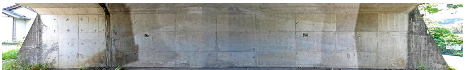
写真4：橋梁壁面の統合画像
